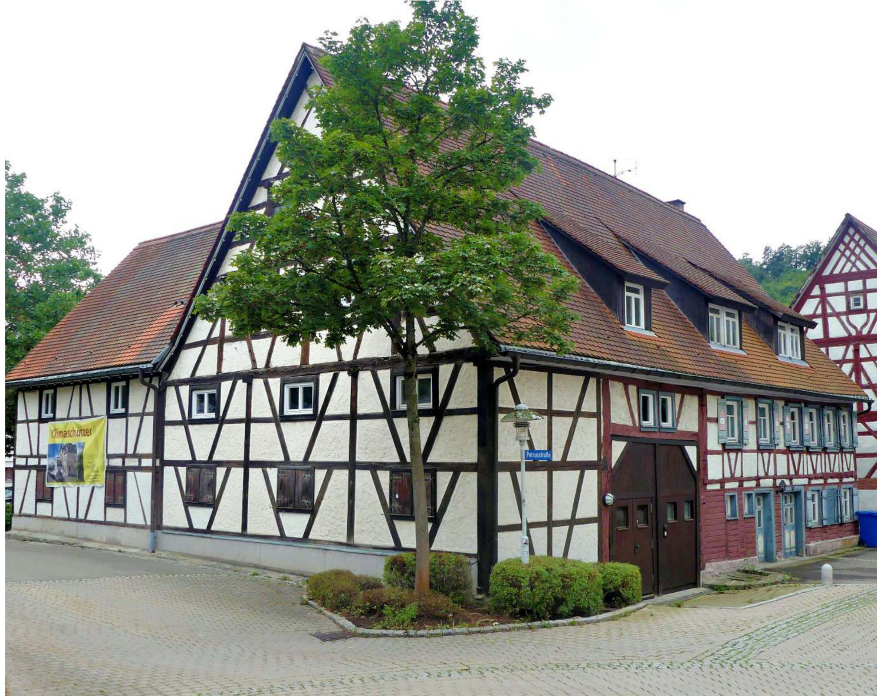
Das Haus der Vereine konnte zuletzt wegen Brandschutzmängeln nur noch teilweise genutzt werden.
